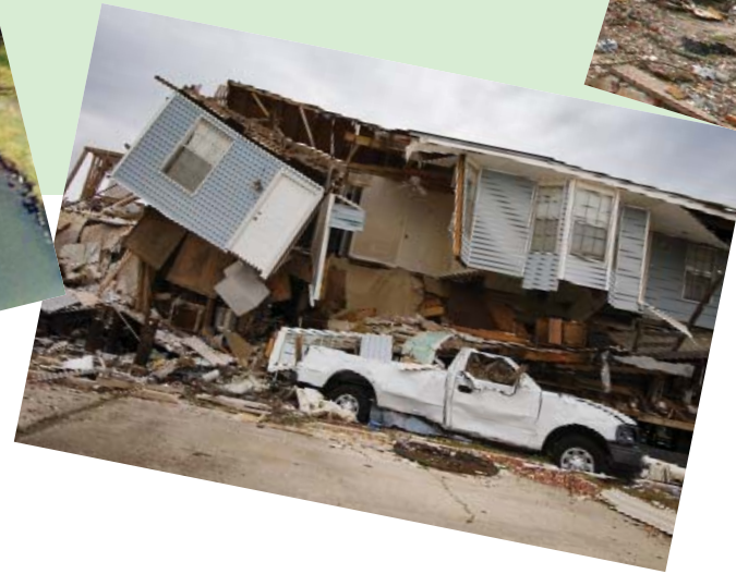
DESTROZOS CAUSADOS POR HURACANES
