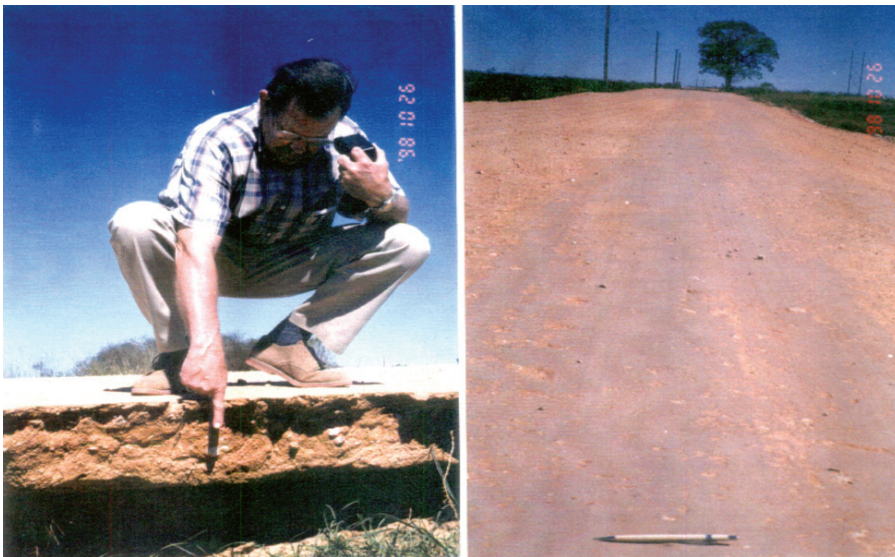
Figura 13. El camino del Condado de Walton conservó la base después del paso del Huracán George, durante el cual socavó la sub-base y se perdió la carpeta asfáltica en algunas zonas. La misma terracería (derecha) muestra la base sin la carpeta asfáltica.
