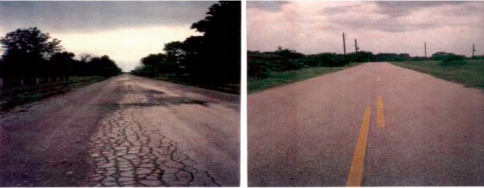
Figura 12. Carretera es Walden Road en Texas, construida en 1987. El tramo de la izquierda, que pertenece a la ciudad no fue estabilizado con Base Seal, el tramo de la derecha perteneciente al condado fue tratado con Base Seal.
