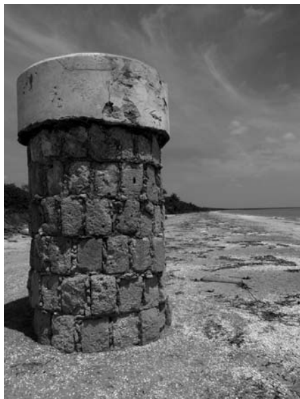
Figura 3. Pozo de 1709 de la ex-hacienda Xicalango. Hace cuatro lustros el brocal de mampostería se encontraba dentro del monte. Hoy día la marea alta lo acecha.
