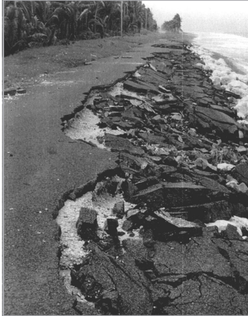
Figura 5. La destrucción de la infraestructura adyacente a la costa, es otro de los problemas que se manifiestan con el ascenso del nivel medio del mar. (Barra de Tupilco, Tabasco).
